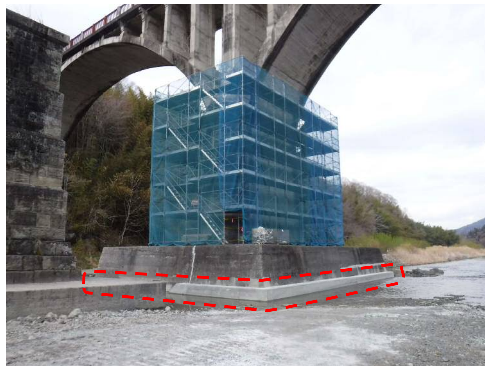
洗堀箇所のコンクリート補修
