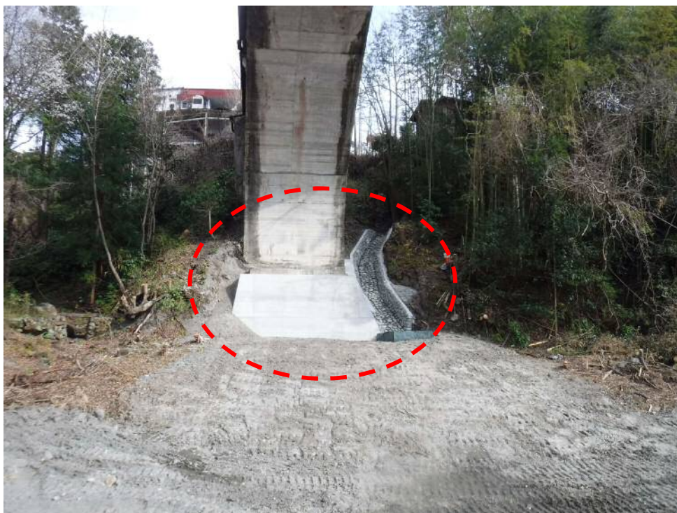
基礎のコンクリート補強
