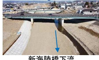
栃木県では、令和元年東日本台風により生じた甚大な被害を踏まえ、河川激甚災害対策特別緊急事業等により、秋山川の河道掘削や築堤を実施。
