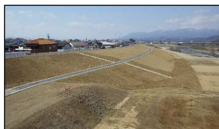
堤防整備の状況 (桐生市相生町地先)
