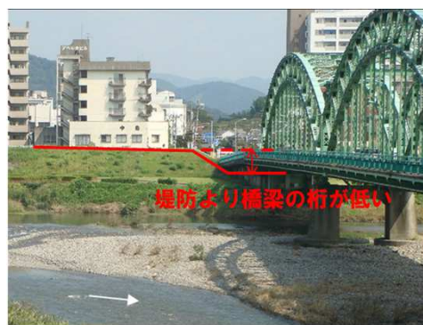
橋梁架替: 中橋(渡良瀬川)
