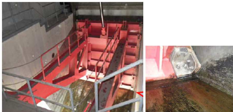
放流設備ゲート(水密ゴム更新)
