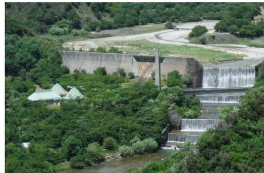
砂防堰堤の整備例
