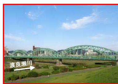
橋梁架替(中橋)
