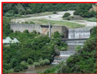
砂防施設の整備(足尾砂防堰堤)
