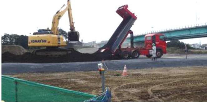
盛土工事状況
