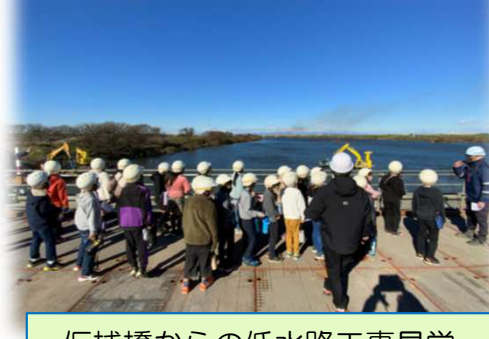
仮栈橋からの低水路工事見学
