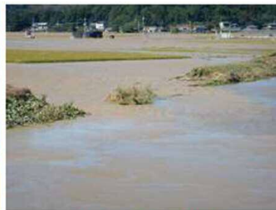
奥戸町 出流川の破堤箇所
