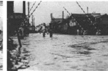
冠水したJR両毛線踏切 (足利市)
