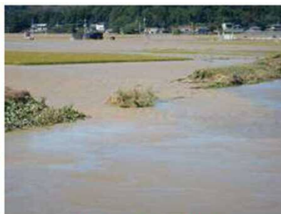
奥戸町 出流川の破堤箇所
