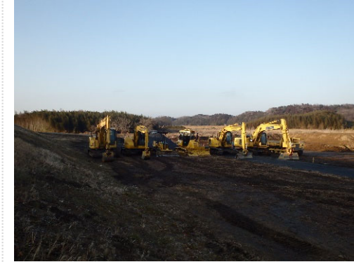
【堤防工事開始】
