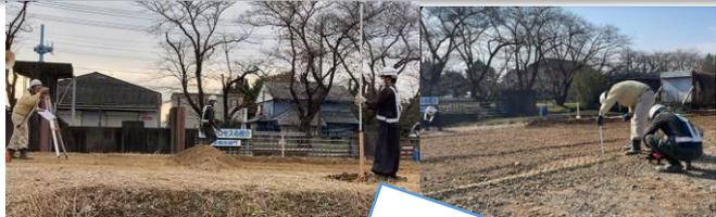
地面に設置した杭に施工高さを示す横板と釘を打ったトンボ丁張りを管理断面の左右端部に設置
