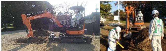
丁張りレス施工による作業効率向上・人員削減・安全性向上
