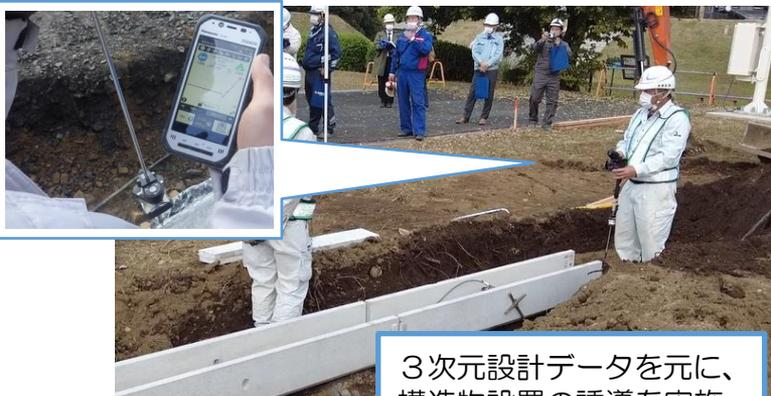
3次元設計データを元に、構造物設置の誘導を実施
