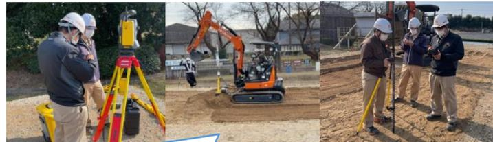
重機への機器設置作業は平均1時間程度（工場で取付け治具の事前溶接・キャリアレゾンをしておけば現地作業を10分程度に短縮可能）
