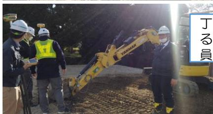
チルトローテートバケット使用によるマシン移動回数の低減(狭小現場でも作業性が低下しない)
