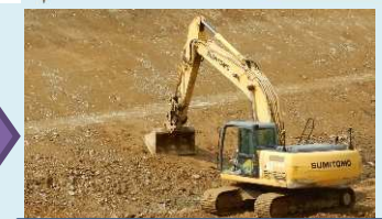
法面整形(ICT建機)
