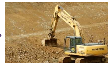
法面整形(ICT建機)
