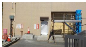
施設鋼製パネルの施工状況
