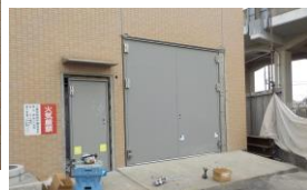
施設鋼製パネルの取付完了
