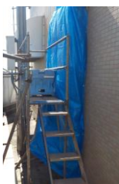
施設鋼製パネルの施工状況
