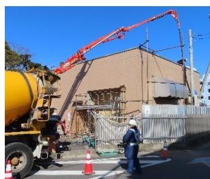
耐水化の施設設置工事を実施
