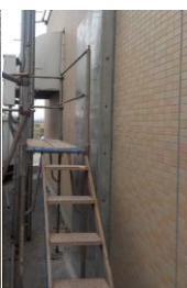
施設鋼製パネルの取付完了
