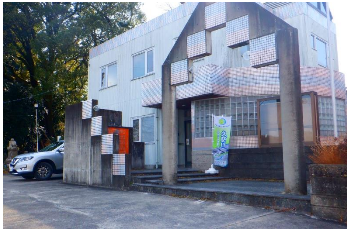
【久慈川緊急治水対策常陸大宮詰所】
