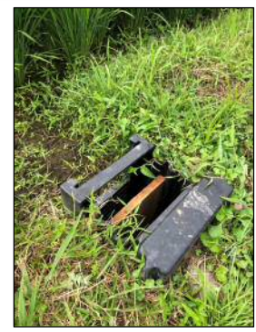
宇都宮市の施工事例
