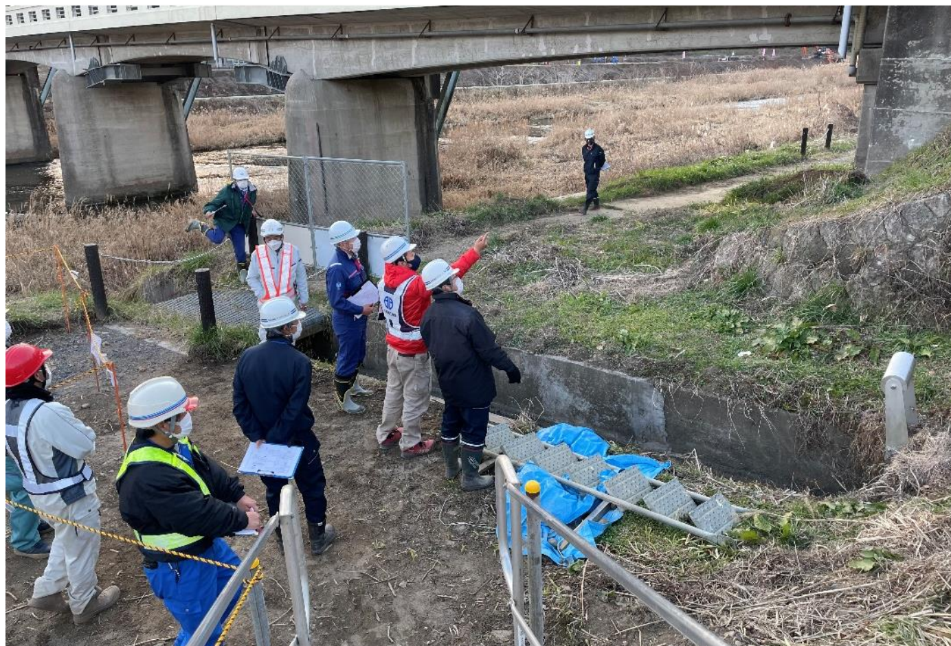
R2久慈川右岸大子地先上流築堤護岸工事（久慈郡大子町大子地先）
