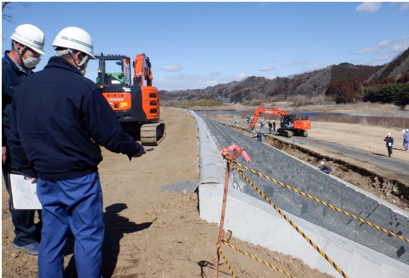
R2久慈川右岸山方地先築堤護岸工事（常陸大宮市山方地先）
