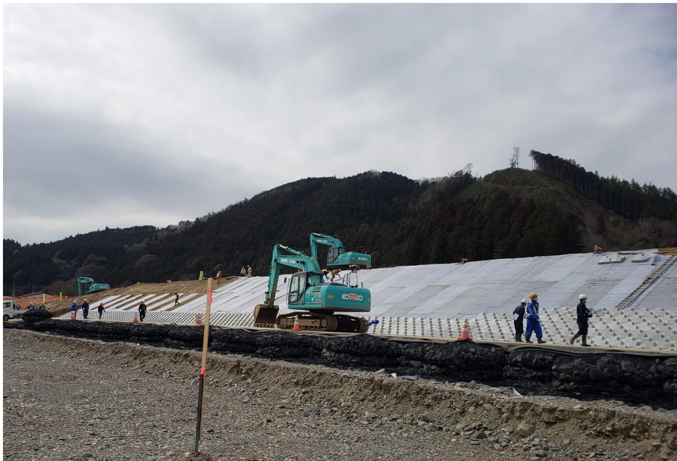
R2久慈川右岸舟生地先築堤護岸工事（常陸大宮市舟生地先）
