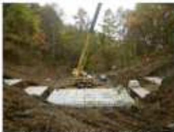
船ヶ沢川西砂防堰堤の施工状況
