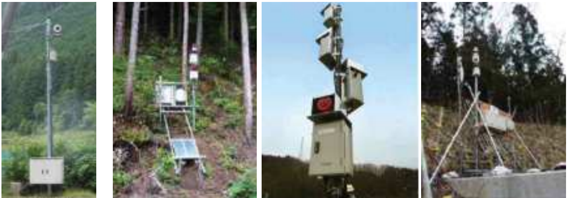
図 7.7 警報局設置事例
