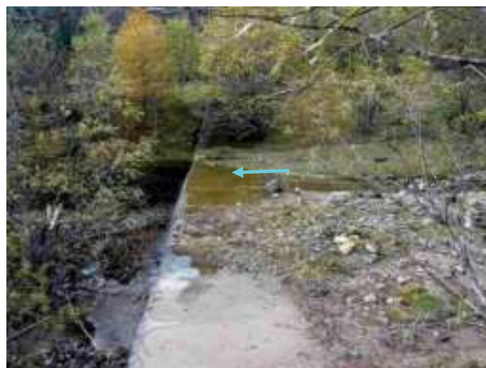
図 8.10 湯川砂防堰堤堆砂域の状況
