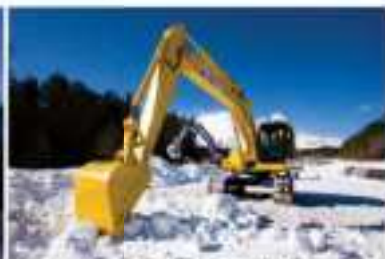
無人化施工による堰脚試験
