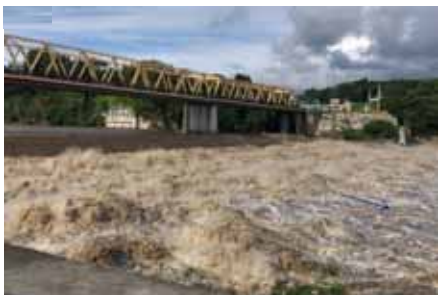
令和元年10月 利根川(渋川市半田付近)
