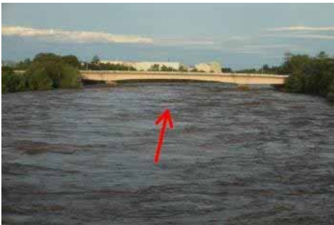
平成25年9月 利根川(玉村町上福島付近)
