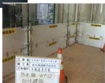
非常用電源設備周囲に整備された防水壁の様子（常総市）
