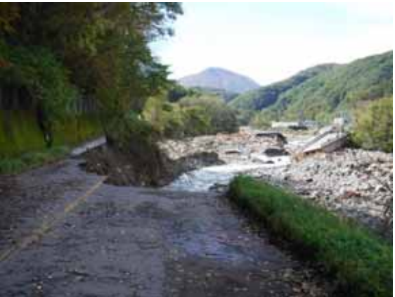
令和元年10月吾妻川(嬬恋村大笹付近)
