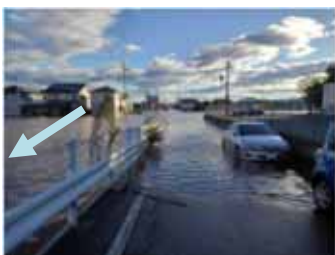
令和元年10月 被災状況
