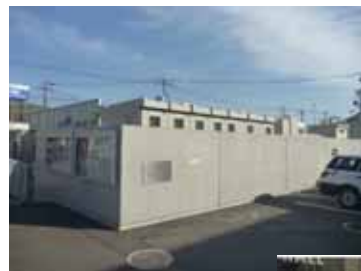
非常用電源設備周囲に整備された防水壁の様子（常総市）
