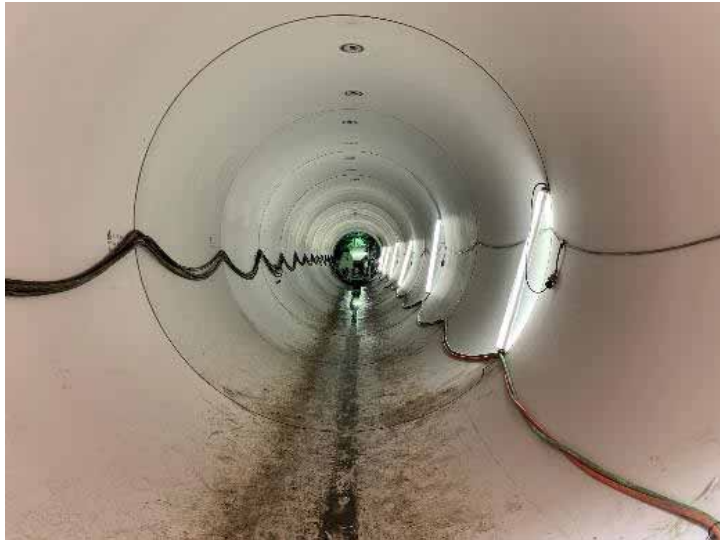
【我孫子市 柴崎雨水幹線整備】
