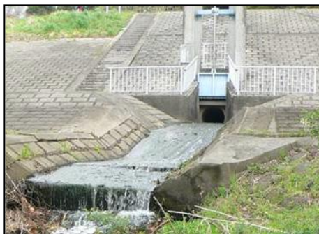
境田排水樋管（整備前） ※1
