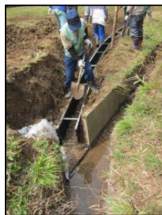
水田魚道の設置 ※1
