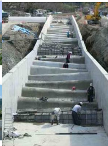
改修前後の神流川頭首工（左）と、魚道（ハーフコーン型）設置の様子（右）※2
