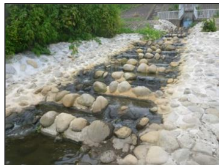
境田排水樋管（整備後） ※1
