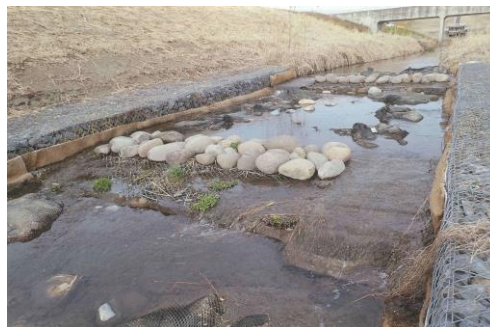
行人樋管に整備された魚道
