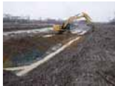
河道掘削 (石狩川水系、北海道開発局)
