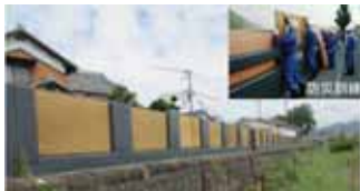
自主防災活動による畳堤設置 (揖保川水系、たつの市)
