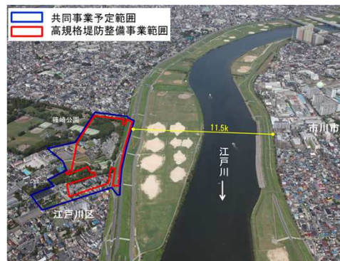
篠崎公園地区高規格堤防整備の実施 (国・東京都・江戸川区)
