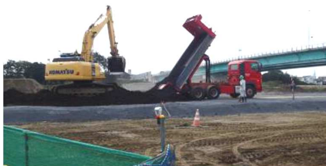
盛土工事状況
