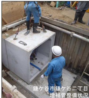
・ 既設の円形管を流下断面確保に有利なボックスカルバートに布設替え。
