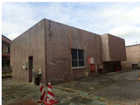
運河出張所発電機室 外観
