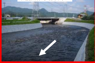
河道掘削(宇都宮市)
