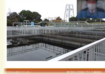
水処理施設の紹介＜④第二沈殿池＞
