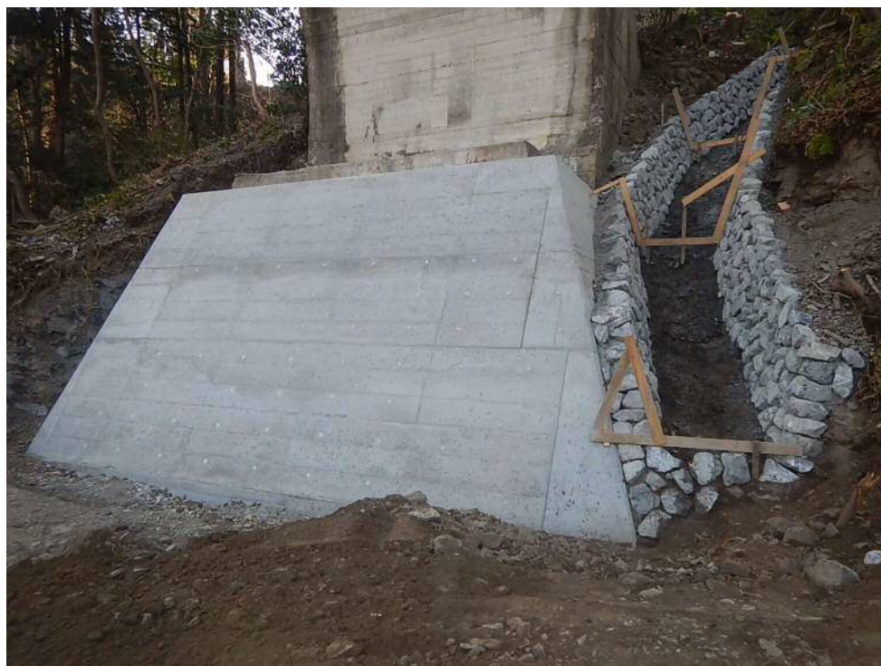
基礎部分の施工状況
