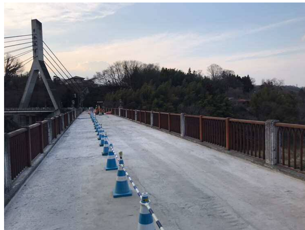
舗装の撤去状況
