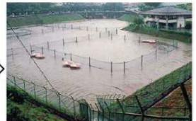
雨水貯留浸透施設の例(防災調整池)
