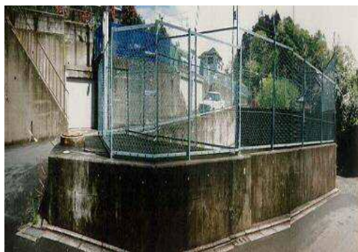
従前の防災調整池
