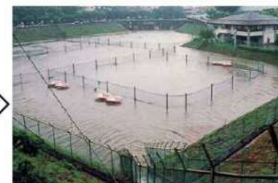
雨水貯留浸透施設の例(防災調整池)
