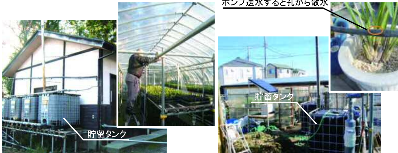
雨水活用施設
