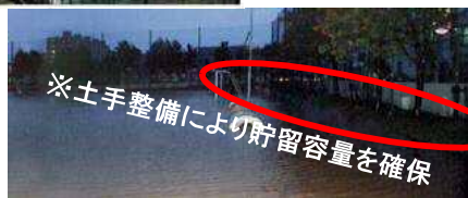
【校庭を活用した貯留施設】
