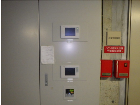
〈自動制御盤改修〉
