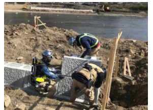
パワーアシストスーツ検証の様子▶
