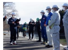
◀工事内容説明時の様子
