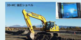
施工(ICT施工)
