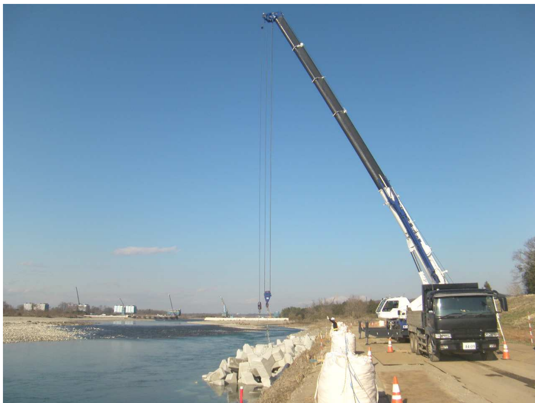
【根固ブロック工 据付イメージ】
