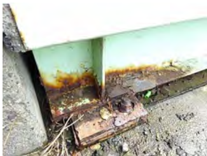
<主桁部分補修>
