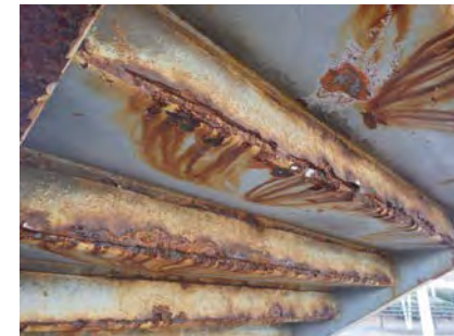
<階段部部分補修>
