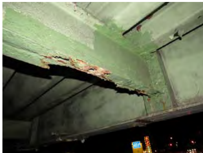
<横桁部分補修>
