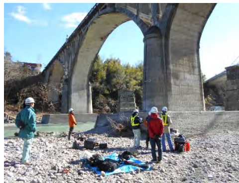
現地でのUAV操作状況
