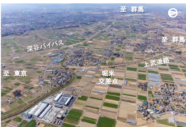
深谷市堀米交差点付近(令和3年3月撮影)
