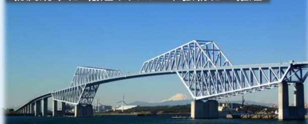
東京港 臨港道路（東京ゲートブリッジ）
