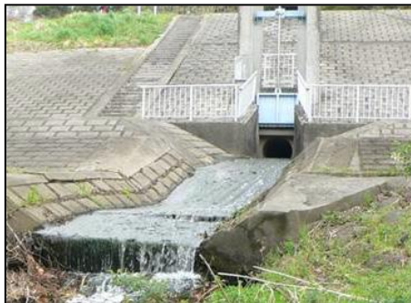
境田排水樋管（整備前） ※1
