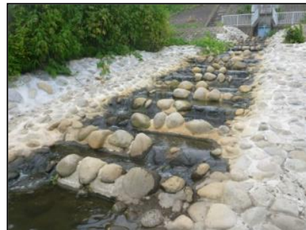
境田排水樋管（整備後） ※1
