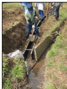
水田魚道の設置 ※1
