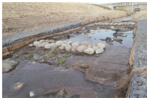
行人樋管に整備された魚道
