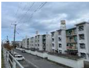
町営前原住宅
