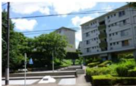
高幡台団地の外観
