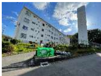
南長津田団地の外観
