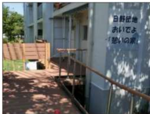
道路から憩いの家へのアプローチ（スロープ、手すり）
