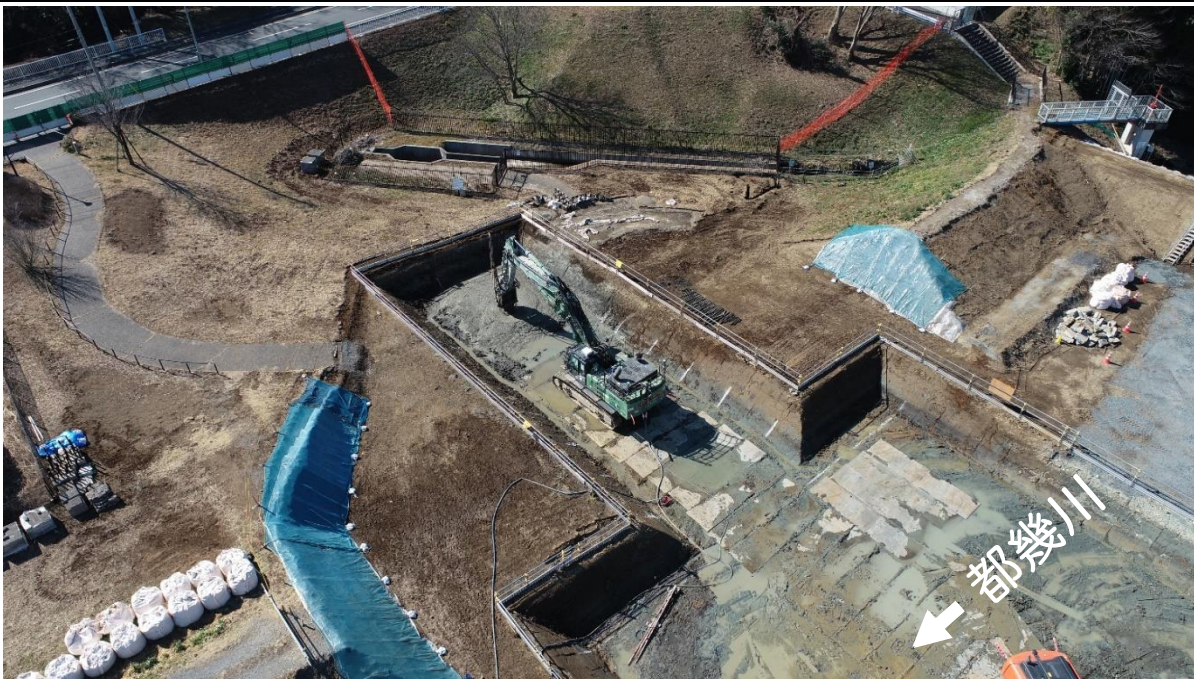
地盤改良工 施工状況
