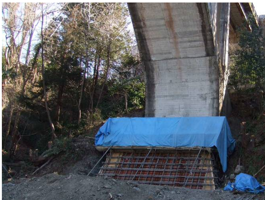
基礎部分のコンクリート補強状況
