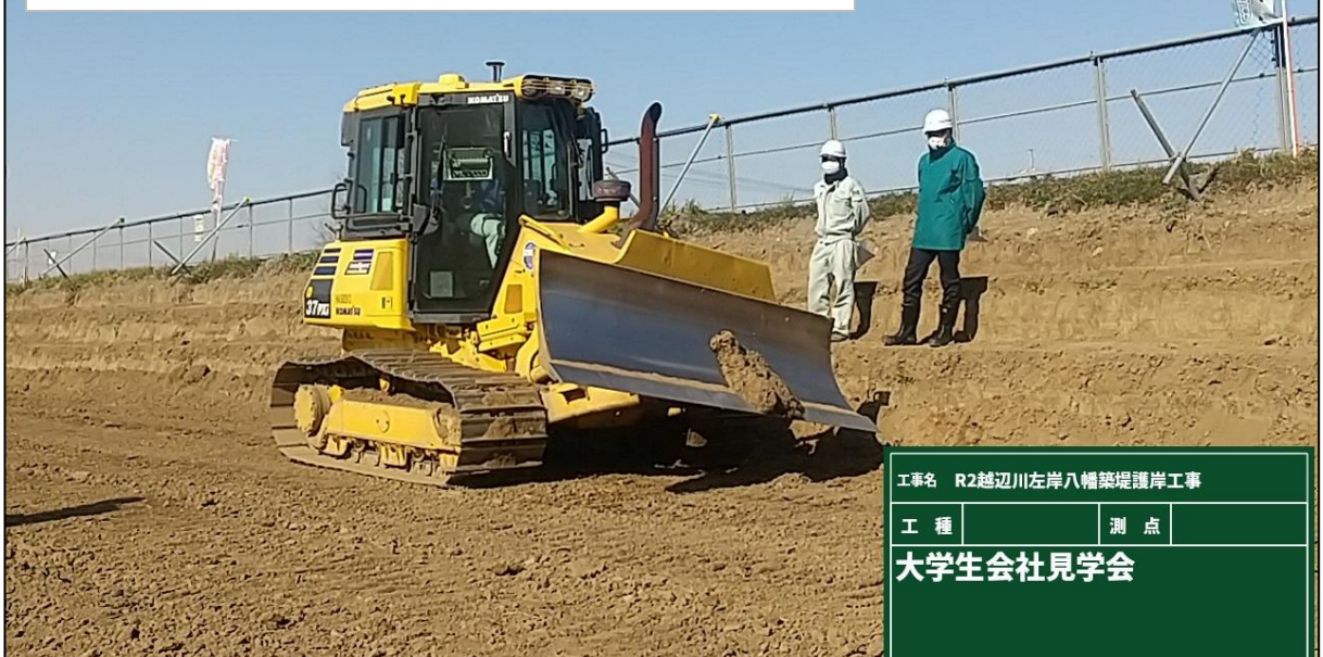
ブルドーザーによる築堤状況 (ICT建機)
