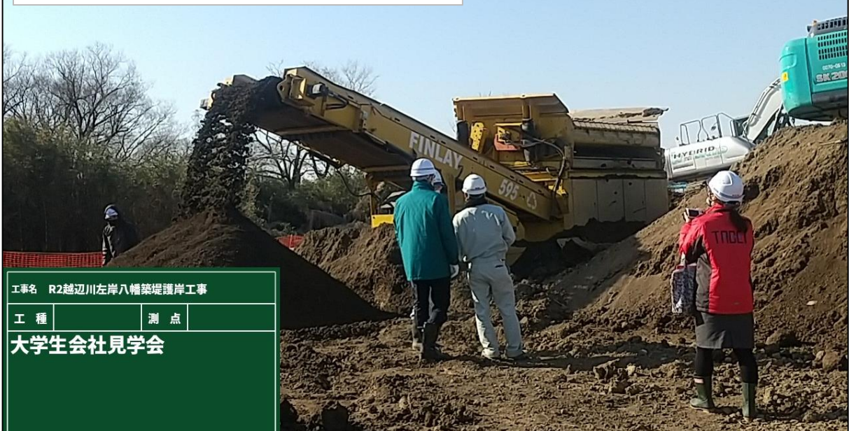
土砂混合機による築堤材の作成状況
