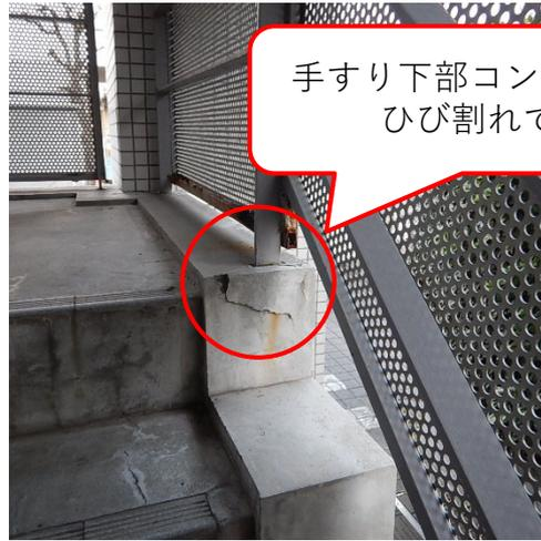
手すり下部コンクリートがひび割れている
