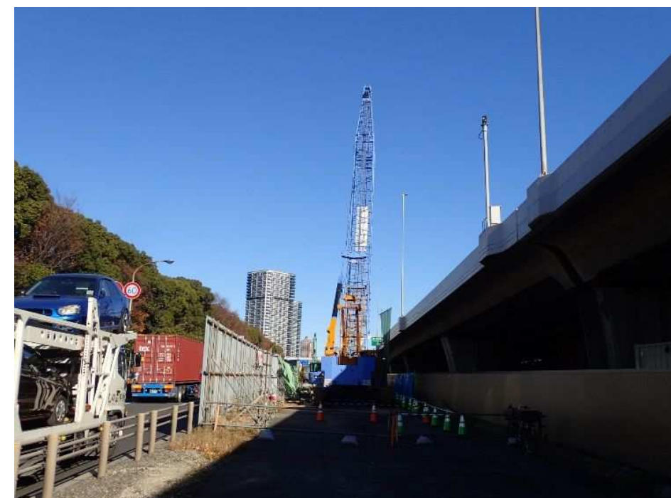
④YP3橋脚~YA1橋台
