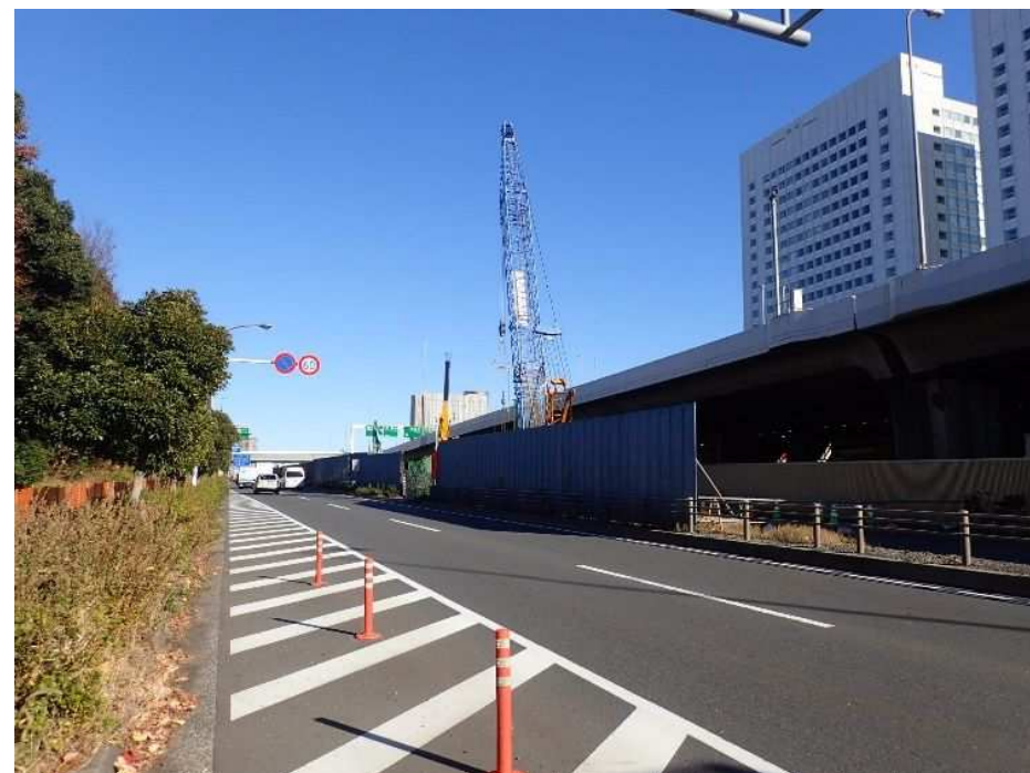
③YP3橋脚~YA1橋台
