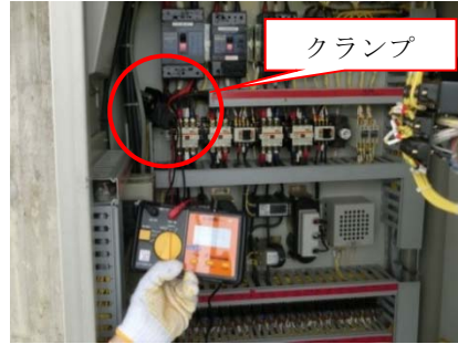
写真-5 漏電測定状況 1
