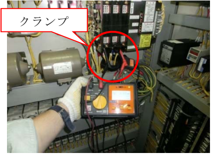
写真-6 漏電測定状況 2
