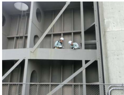
写真-8 板厚測定状況
