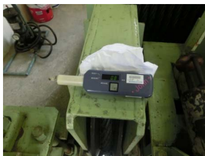
写真-15 グリス鉄粉濃度診断状況
