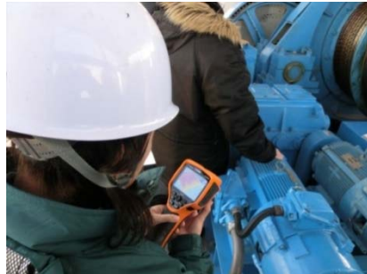
写真-2 赤外線サーモグラフィ測定状況
