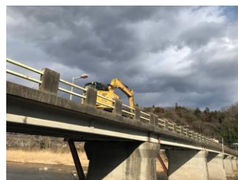
▲撤去工事の様子
