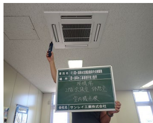
室内機点検中
