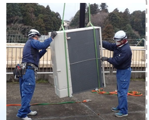
室外機搬入中
