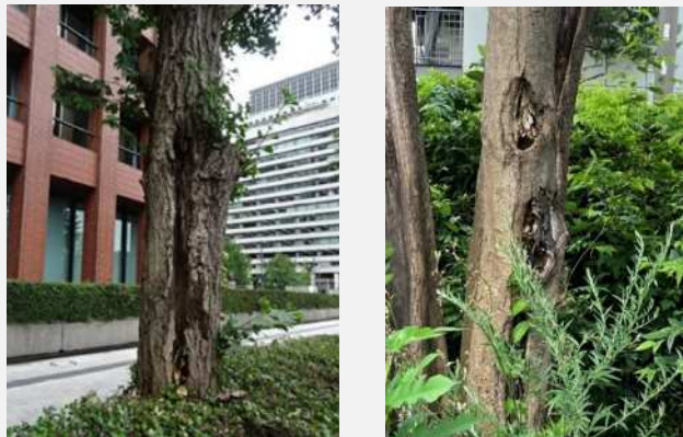
大枝剪定痕から発生した幹腐朽
